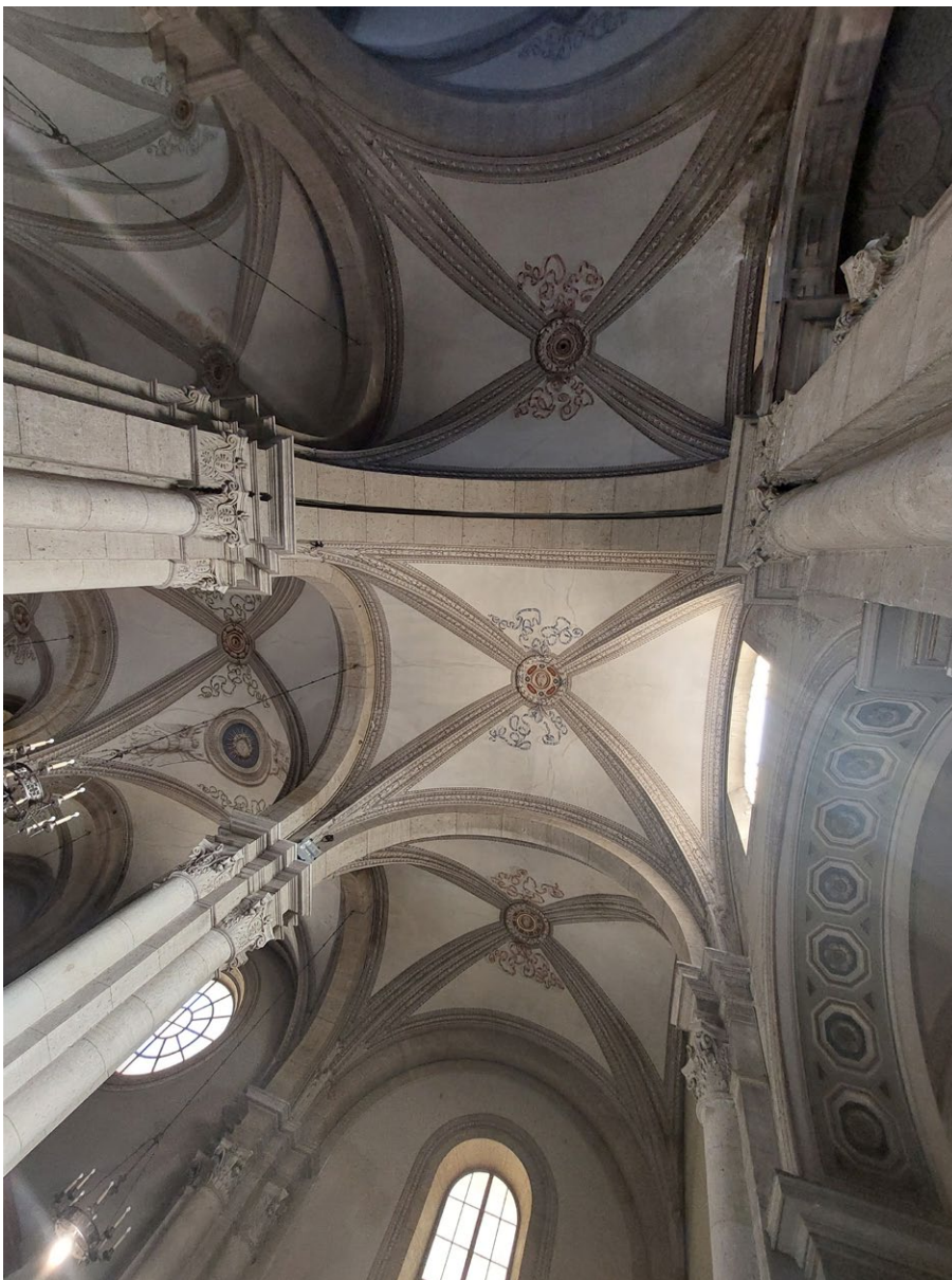
Fig. 9. Bóvedas y soportes de la nave del Evangelio en las que se observa el cambio del planteamiento constructivo entre las naves originales y las de esta primera ampliación de la iglesia con una doble arcada que funciona como junta estructural (Foto de la autora).
